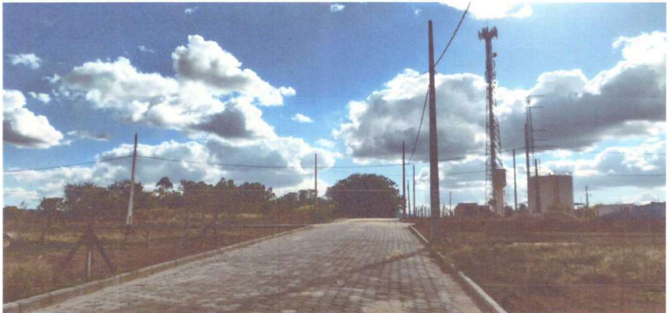
Foto 01: instalação de poste no loteamento Therezinha Albieri de Sousa – Rua Prof. Izabel Maria de Oliveira Silva
